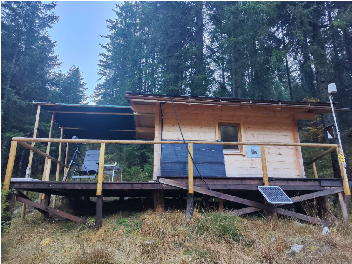
Abbildung 2: Die neue Monitoring-Hütte in der Halsgrube. Quelle: NPV
