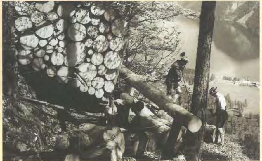
Dieses Bild aus dem Jahr 1934 zeigt die letzten Vorbereitungen für den trockenen Holzsturz an der Burgstallwand. Die herangeschafften Rundlinge sind auf der „schiefer Ebene“ der Absturzstelle fertig aufgeschichtet. Der Holzsturz kann beginnen. Das Abhacken des Haltebaumes, auch Sperrbaum genannt, war für die Waldarbeiter eine besonders gefährliche Aufgabe.
